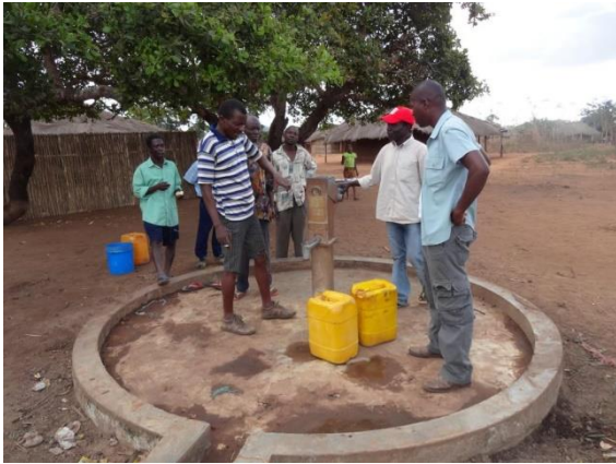
Foto 7: Fonte de água reabilitada com os 20%
