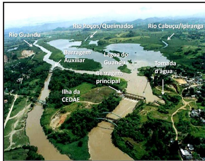
Figura 12 – Captação ETA Guandu
