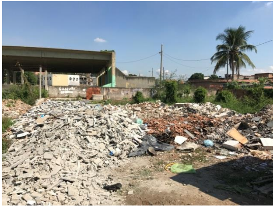
Figura 16. Ponto A na Figura 14. Entulhos e outros descartes de construção que formarão a base das futuras casas. Fonte: o autor
