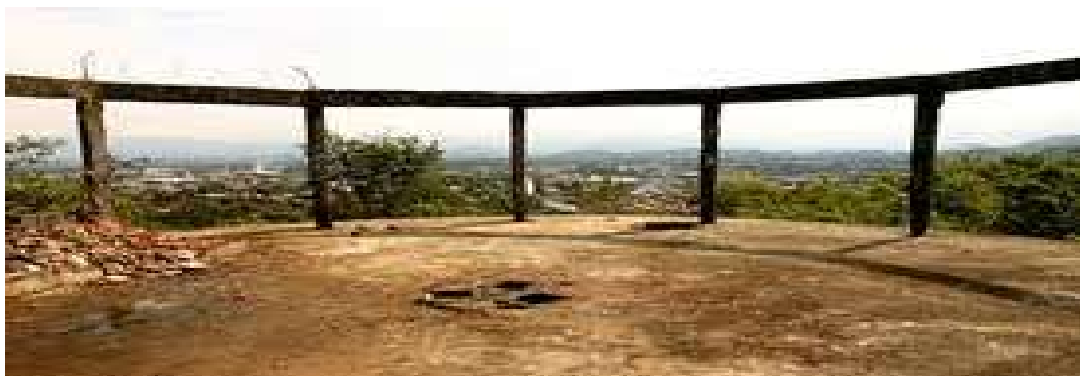
Figura 17 - Caixa D'água no Topo de Morro do Parque. Fonte: CAXIAS MAIS VERDE (2010).
