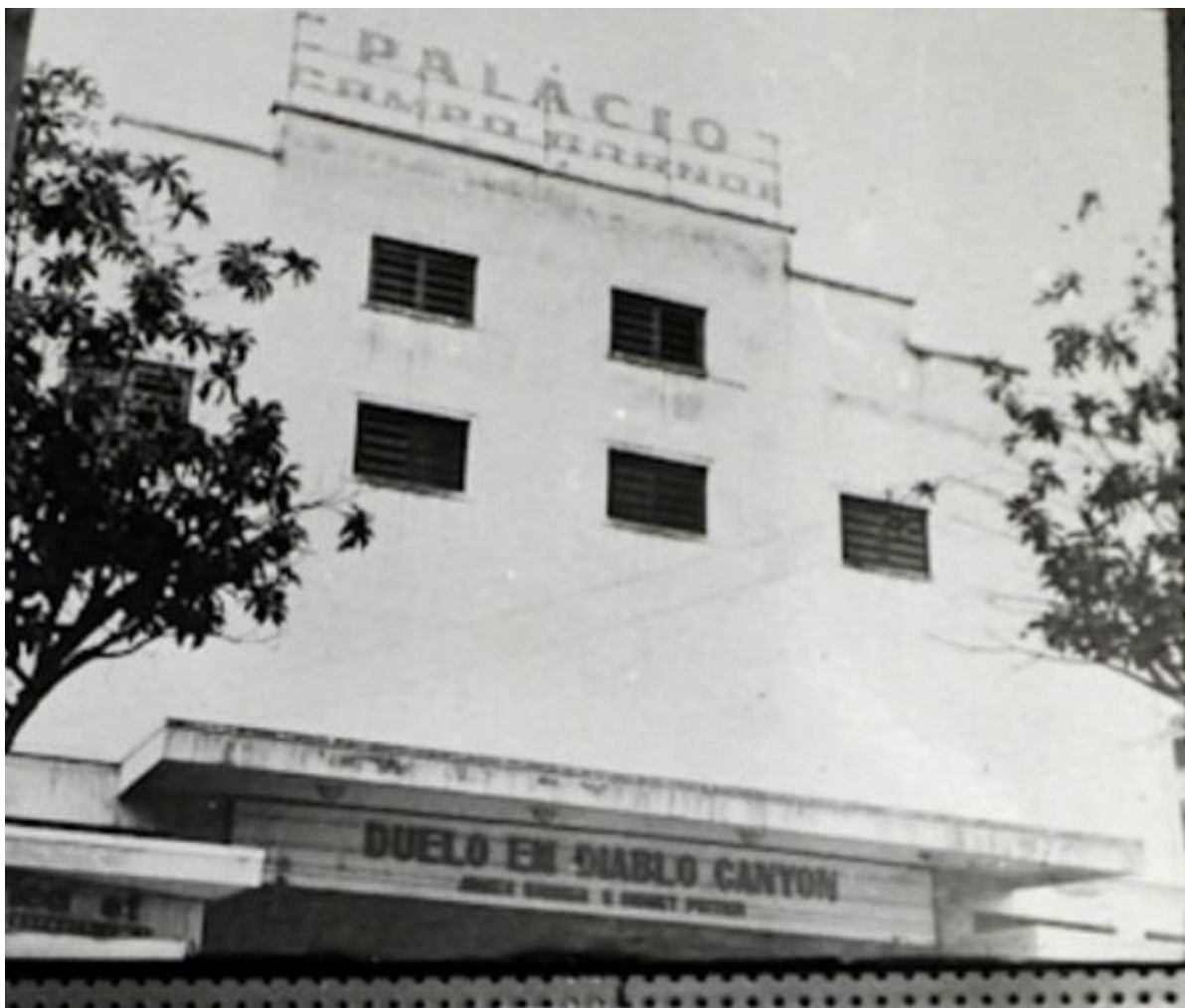
Figura 33. Registro do Cine Palácio Campo Grande S/d. Seu formato de cinema permanece preservado, porém cedeu lugar à Igreja Universal do Reino de Deus desde a década de 1990. Foto: Arquivo Geral da Cidade do Rio de Janeiro. Fonte: Historiador Guaraci Rosa.
