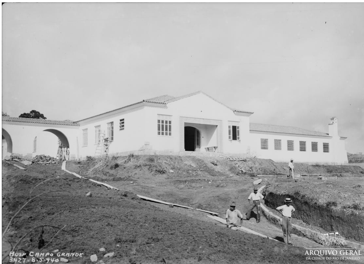
Figura 23. Registro da construção do Hospital Rocha Faria. Fonte: AGCRJ, 1940. Disponível em: http://brasilianafotografica.bn.br/brasiliansa/ Acesso em: 11/02/2020.
