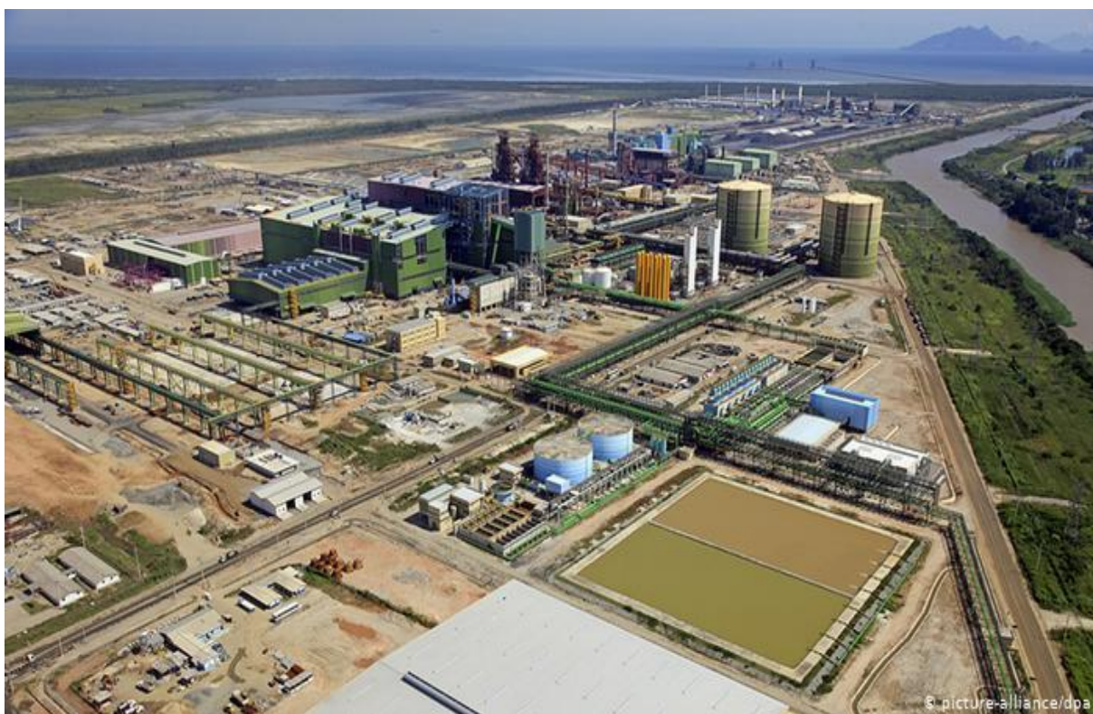
Figura 20: Estrutura da siderurgia vista pelo alto. Fonte: Chuva de prata na Baía de Sepetiba. Disponível em: < https://www.dw.com/pt-br/chuva-de-prata-na-ba%C3%ADa-de-sepetiba/a-16378347 >. Acesso em: 04/02/2020.
