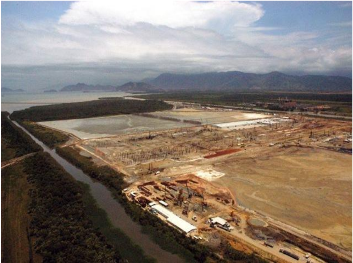
Figura 17: CSA, em Santa Cruz, ainda em construção. Fonte: Fotos e Vídeos das obras da CSA – Thyssen. Disponível em: < https://diariodorio.com/fotos-e-videos-das-obras-da-csa-thyssen/ >. Acesso em: 04/02/2020.
