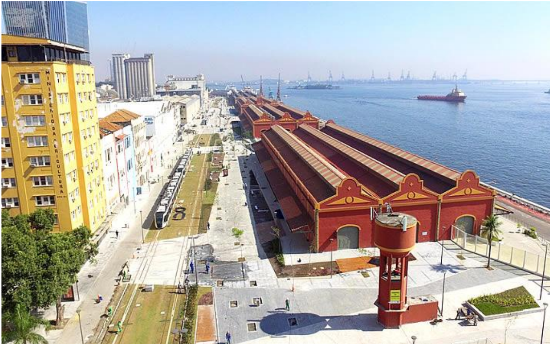
Figura 8- Armazéns no Píer Mauá após as obras de reestruturação urbana. Símbolos do Porto Maravilha, esses armazéns que hoje têm um novo uso, antigamente eram usados somente para funções portuárias. Nessa foto também se destaca os trilhos do VLT (Veículo Leve sob Trilhos), que corta o centro da cidade, assim como antigamente os bondes o faziam.
