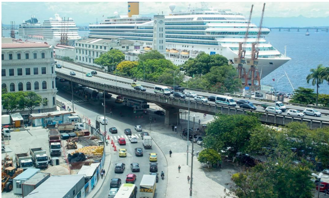
Figura 7- Elevado da Perimetral antes das obras na Zona Portuária. Na foto quase não se percebe a Praça Mauá, que com a reforma urbana ganhou destaque e um aumento em sua área total.
