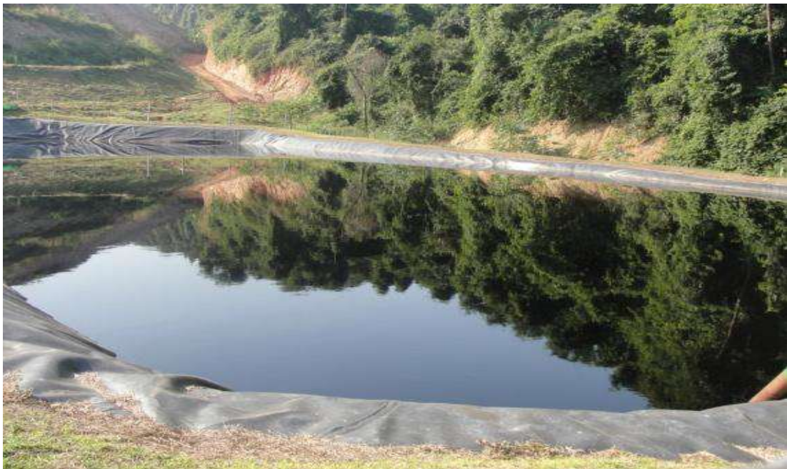
Figura 23: Impactos ambientais do lixão desativado
