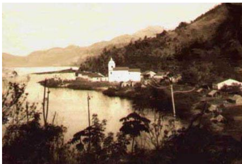
Figura 23 - Freguesia de Nossa Senhora do Rosário de Mambucaba. Material fotográfico cedido por Milton Barros - Mambucaba, RJ.
