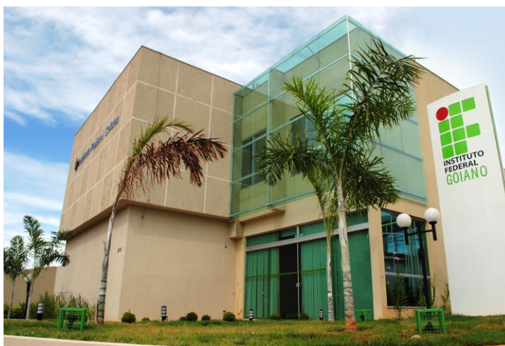
Figura 13 - Prédio da Reitoria
