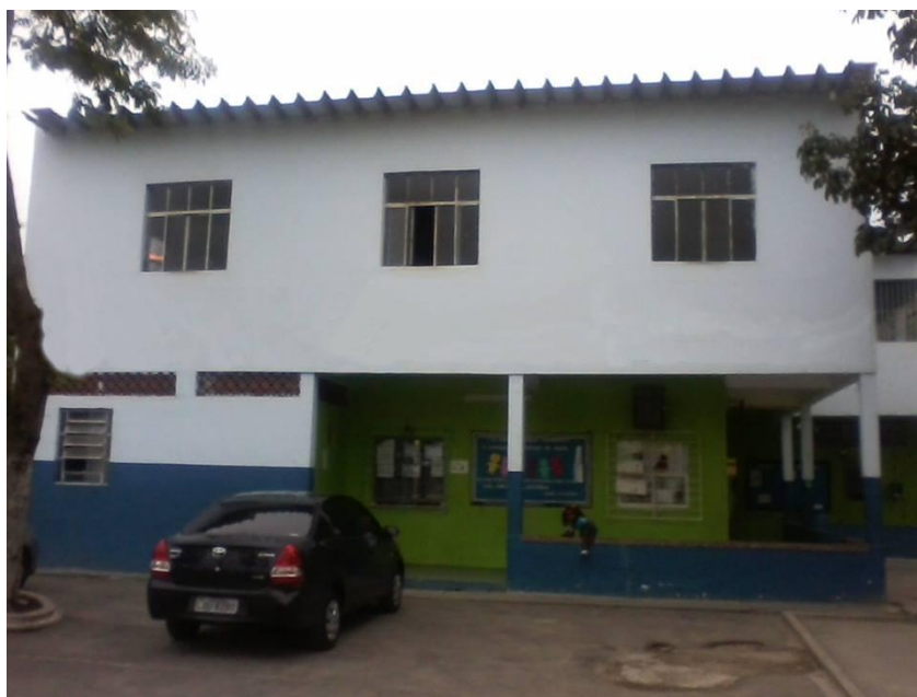
Figura 08 _ Fachada principal da Escola Municipal André Rebouças
