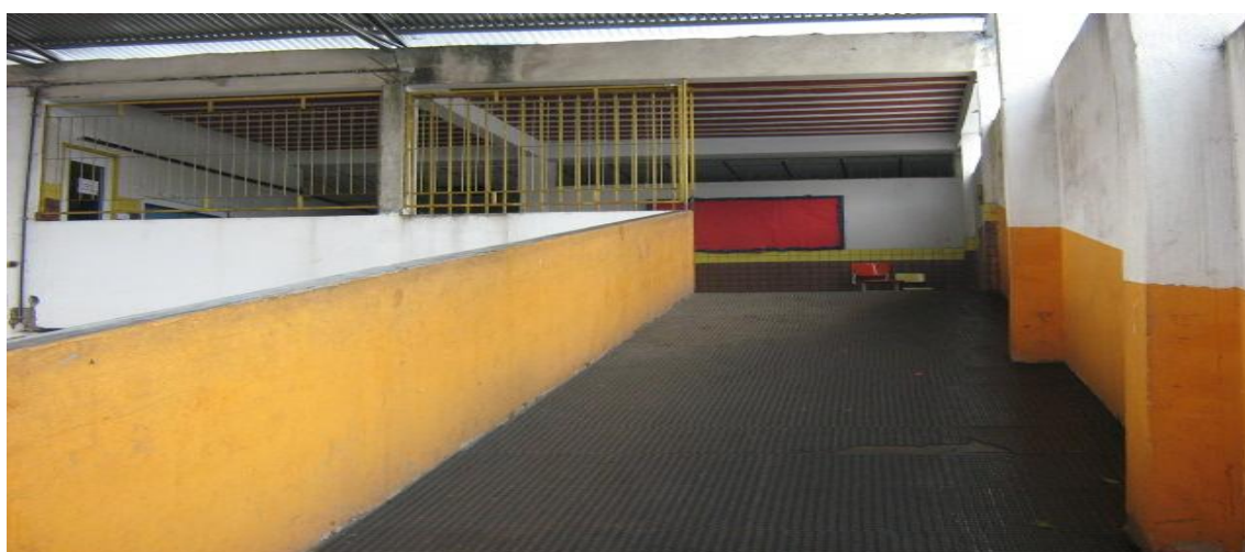
(Figura 3 – Rampa de acesso ao 2º pavimento)
