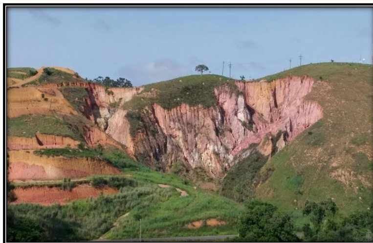
Figura 13. Erosão na forma de voçoroca. Fonte: João Henrique Gaia Gomes (2015).
