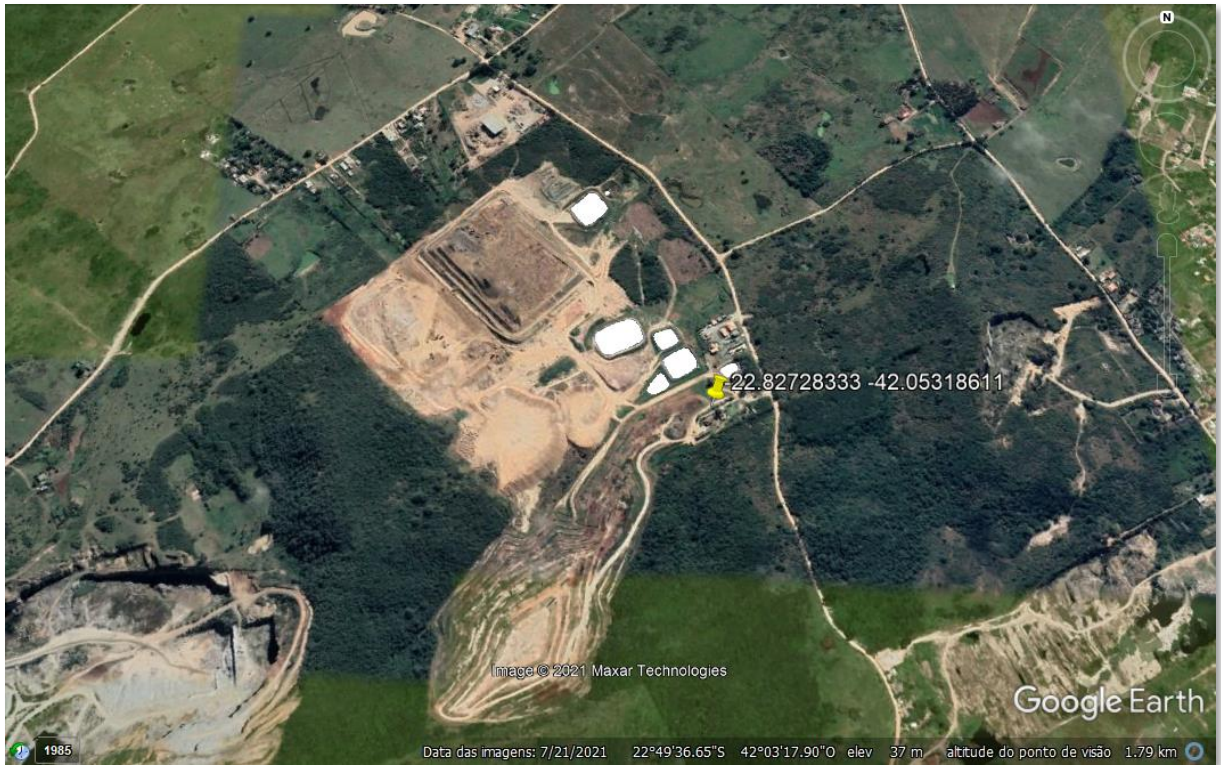
Figura 32. Aterro de São Pedro da Aldeia Fonte: Google Earth
