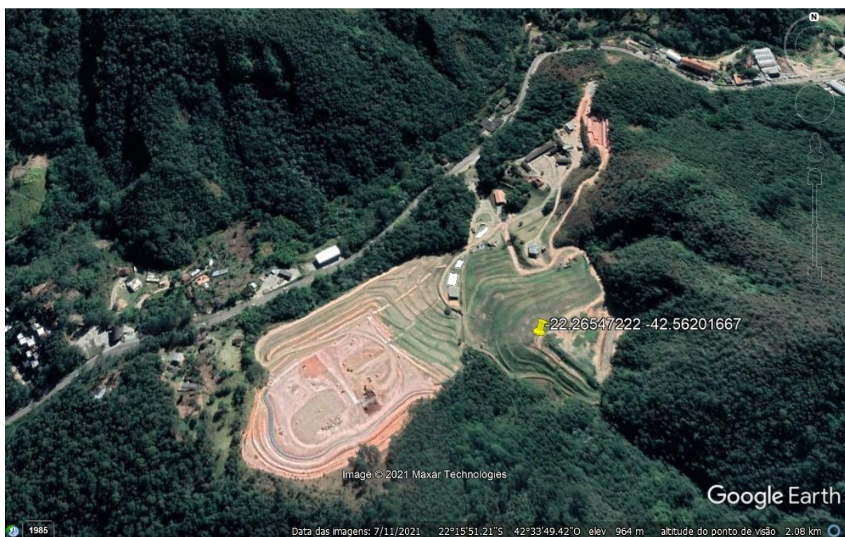
Figura 39. Aterro de Nova Friburgo Fonte: Google Earth
