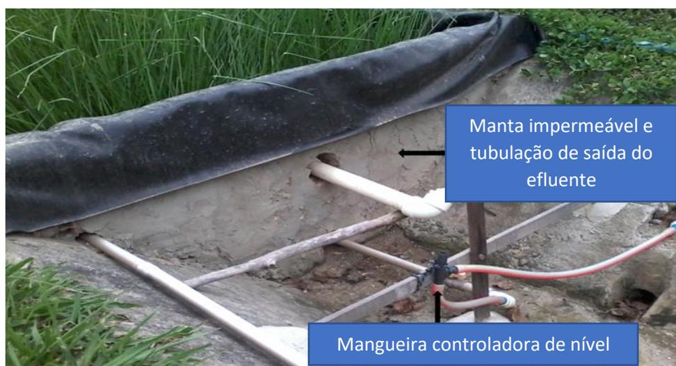
**Figura 8.** Detalhe do canal trapezoidal de concreto, da parede perpendicular ao seu comprimento sustentando a manta de impermeabilização e da mangueira controladora de nível.
