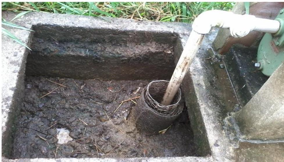
**Figura 3.** Esterqueira com o efluente a ser tratado. Bomba de sucção e tela de arame ao redor do tubo para evitar entupimento.
