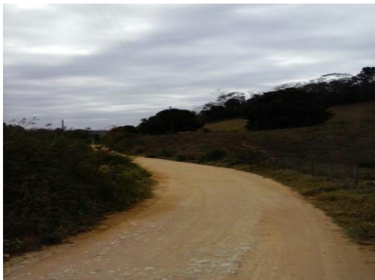
Figura 02 -Estrada de Acesso a Comunidade Remanescente de Quilombo de Monte Alegre (Fonte: Arquivo Pessoal)
