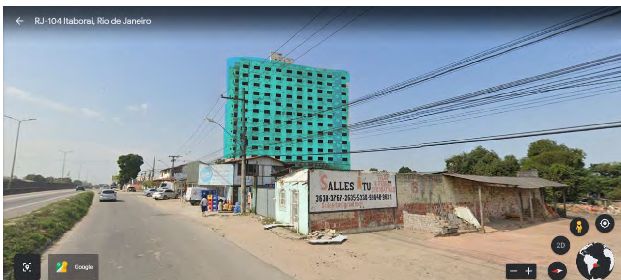
Figura 32 – Prédio abandonado em Manilha – Itaboraí
