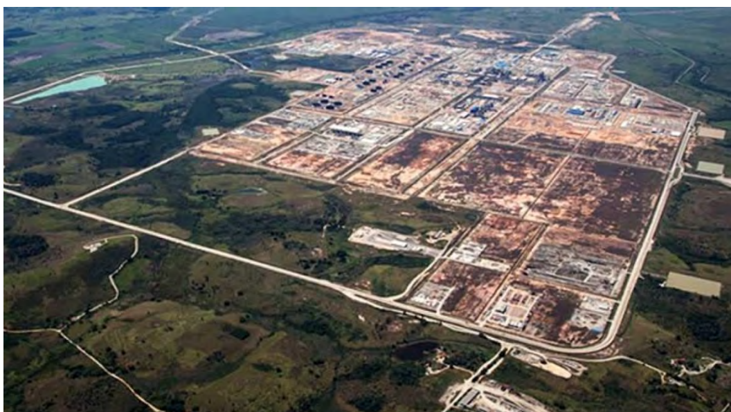
Figura 14 – Complexo Petroquímico do Rio de Janeiro – Itaboraí
