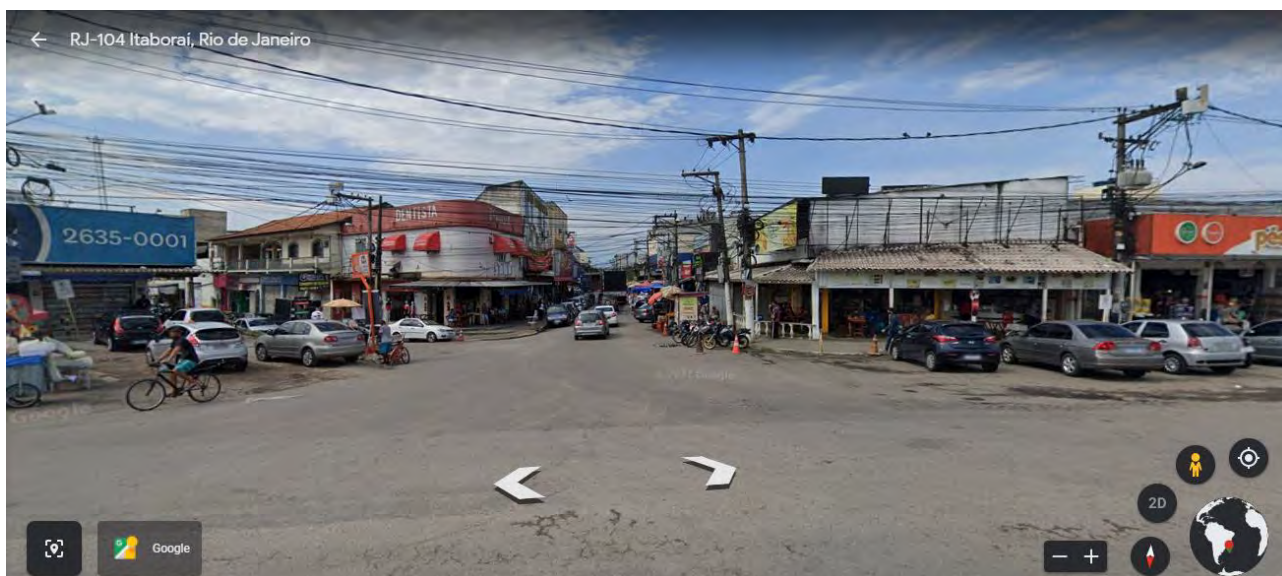
Figura 29 – Entrada centro de Manilha – Itaboraí
