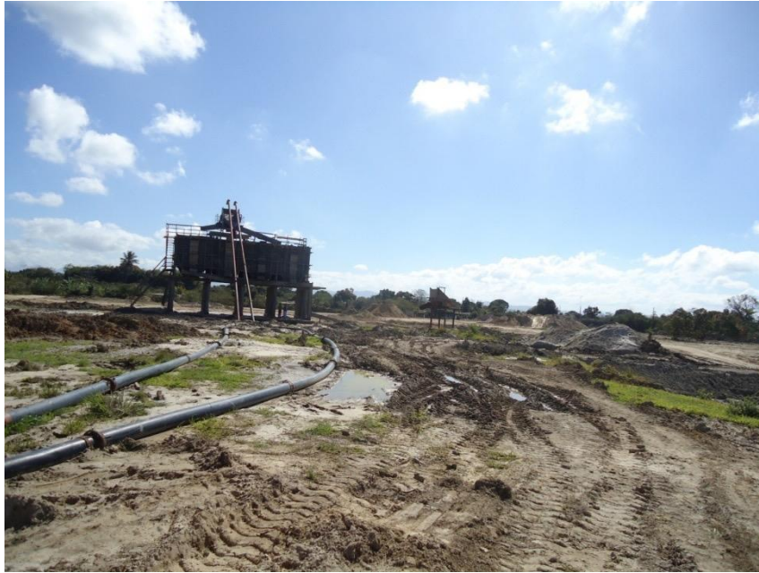
FIGURA 79: INSTALAÇÃO DO SILO
