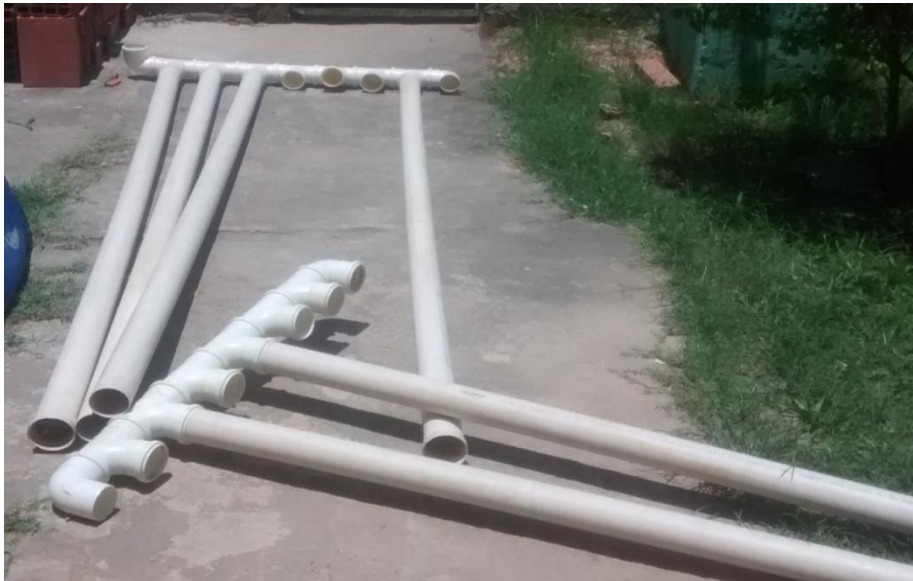
FIGURA 14: Estrutura do canteiro com dimensões de 6m por 1,5m, e conexões ligando os tubos
