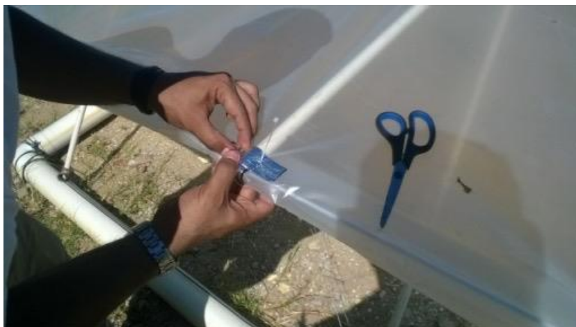
FIGURA 42: Confeção da cobertura de base
