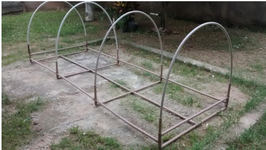
FIGURA 29: Estrutura externa em arco, para melhor circulação de vento
