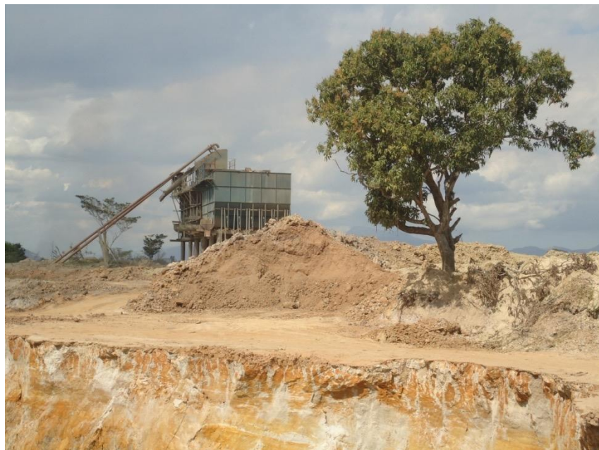
FIGURA 70: SILO COM SISTEMA DE PENEIRAMENTO
