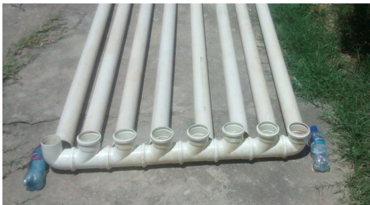
FIGURA 26: Preenchimento dos tubos, laterais externos com PET's de 600 ml
