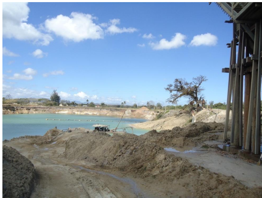
FIGURA 72: ABERTURA DO CANAL PARA LAGOA DE REJEITO
