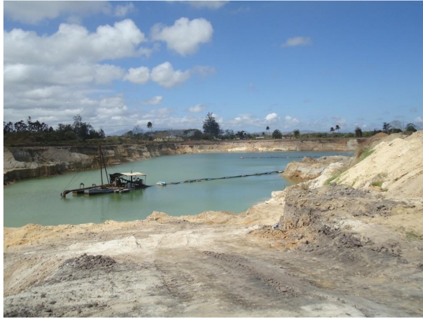
FIGURA 71: INÍCIO DO TALUDAMENTO
