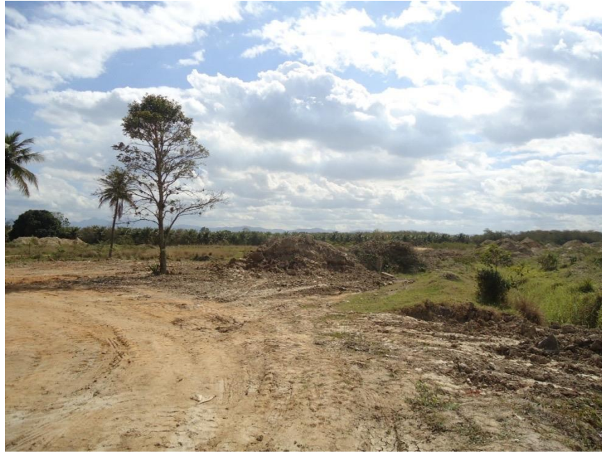
FIGURA 61: ABERTURA DE NOVA ÁREA COM A RETIRADA DA CAMADA SUPERFICIAL
