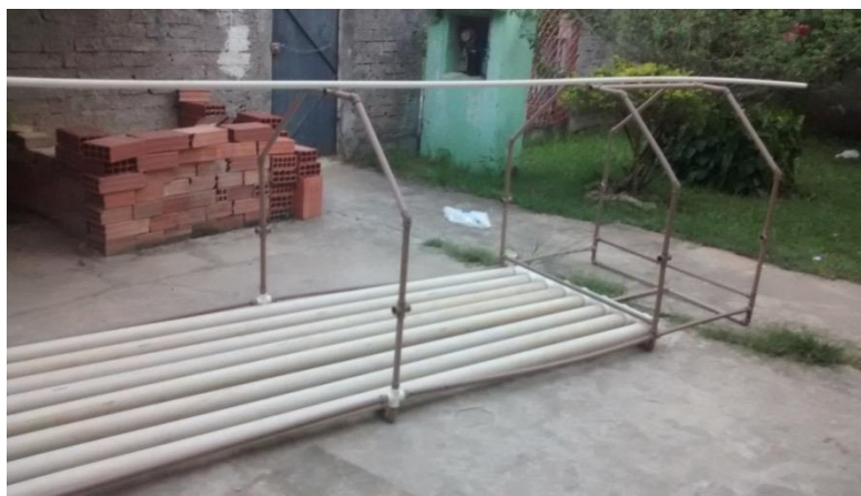
FIGURA 27: Estrutura em pentagono para cobertura
