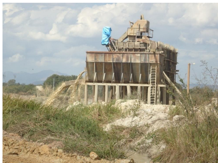
FIGURA 60: CAIXA DE SILOS DE AREIA E LAVAGEM
