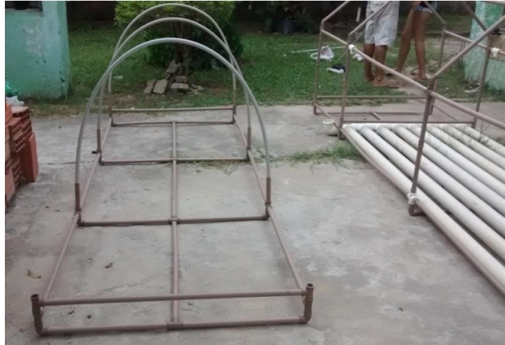
FIGURA 28: Estrutura externa em arco para cobertura
