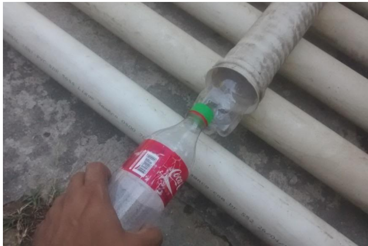
FIGURA 25: Preenchimento dos tubos com PET's de 600 ml
