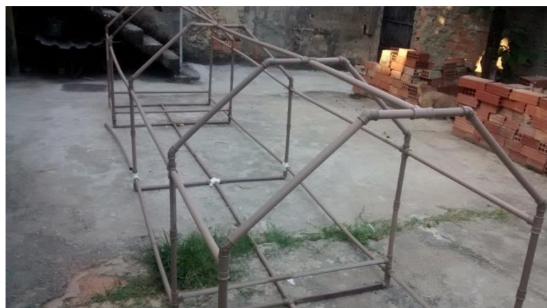
FIGURA 17: Construção da cobertura
