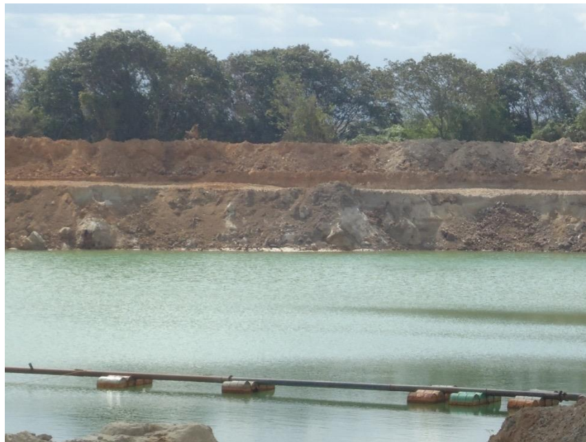
FIGURA 64: ESTABILIZAÇÃO DOS TALUDES DA LAGOA
