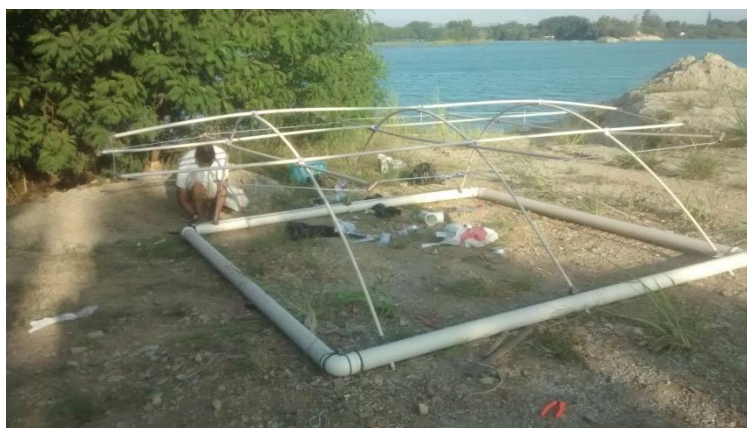
FIGURA 39: Estrutura do canteiro retangular de 3m X 3m , 9m 2
