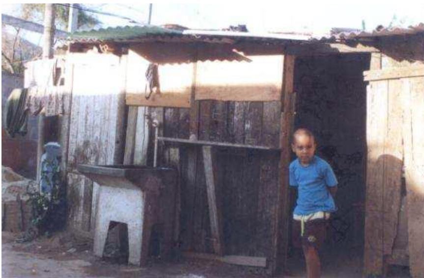
FIGURA 3: Barracos alugados sem água, luz, sem infraestrutura: 01 banheiro para atender 16 famílias
