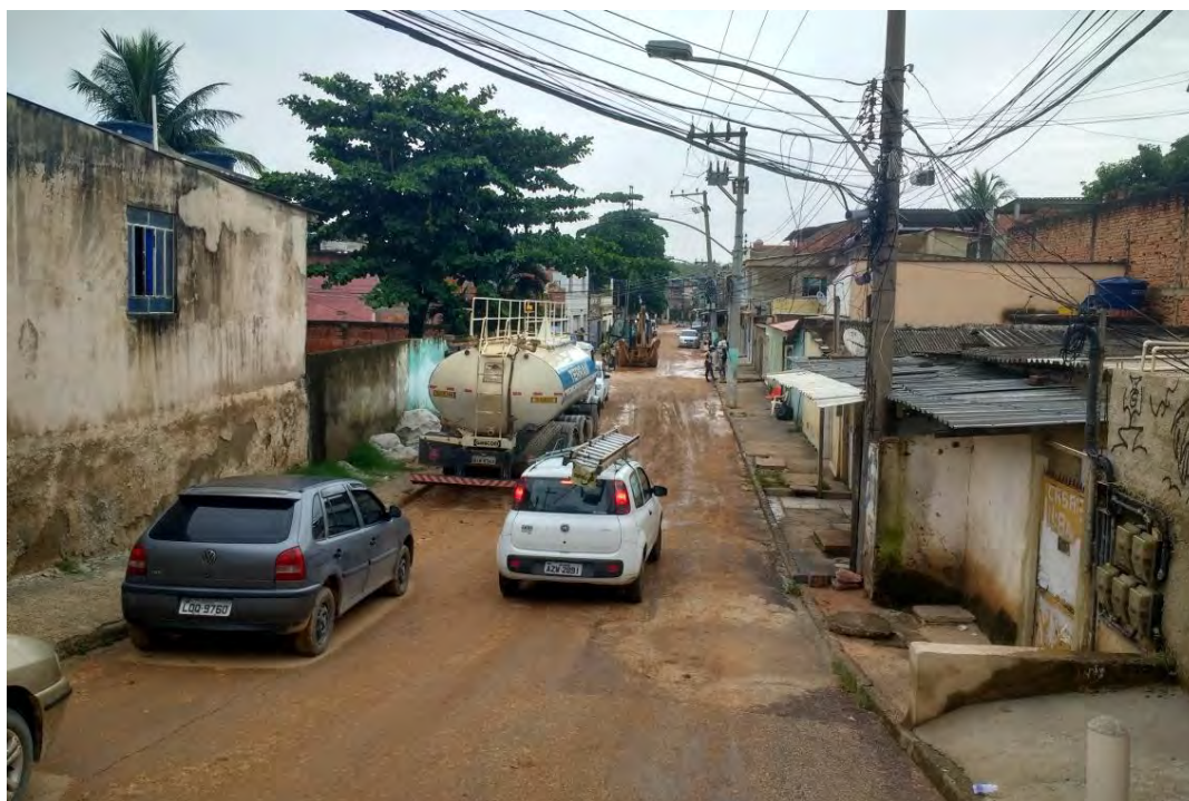
Figura 22: Rua no Bairro Venda Velha, após alagamento que encobriu a rua; desníveis, barreiras, ocupação irregular e postes nos passeios, rua sem drenagem pluvial. (Fonte: Autor, 2018)
