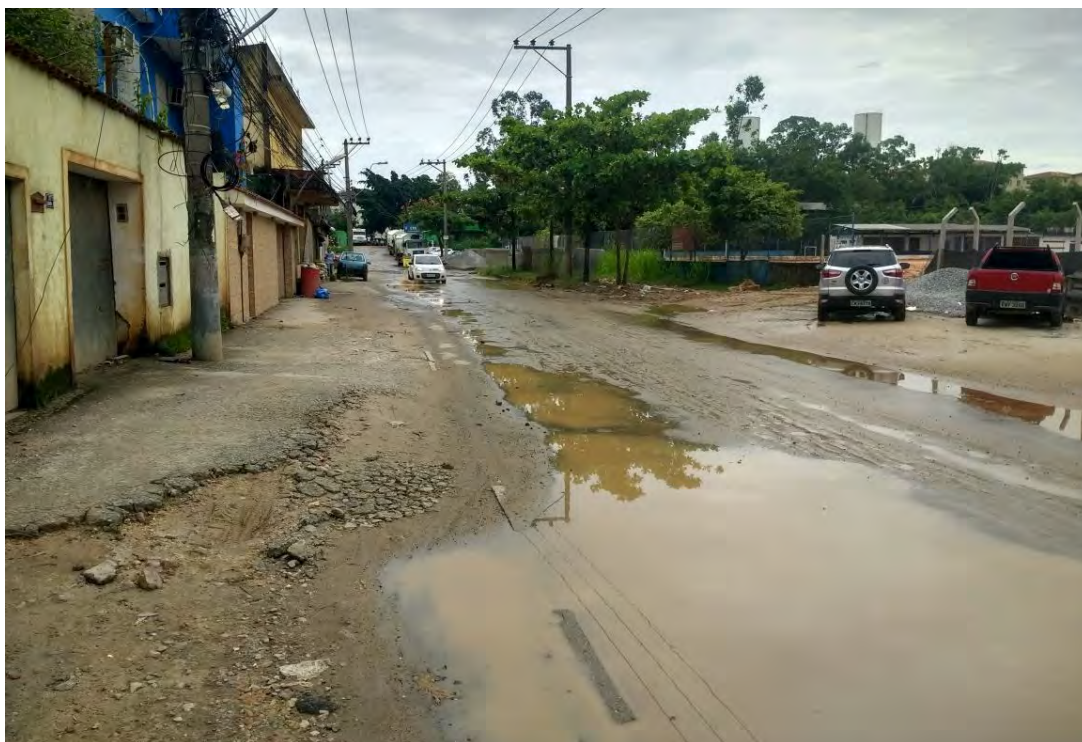
Figura 21: Rua no Bairro Venda Velha após fortes chuvas que deixaram pontos de alagamento, bem como destruição da calçada (Fonte: Autor, 2018)
