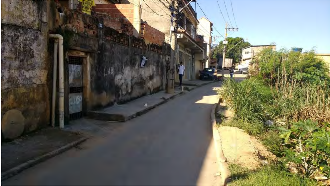
Figura 19: Rua no Bairro Jardim Meriti, próximo ao entroncamento entre a Via Dutra e a Av. Automóvel Clube. Note-se os problemas de desníveis e falta de pavimentação dos passeios. Fonte: Autor, 2018.
