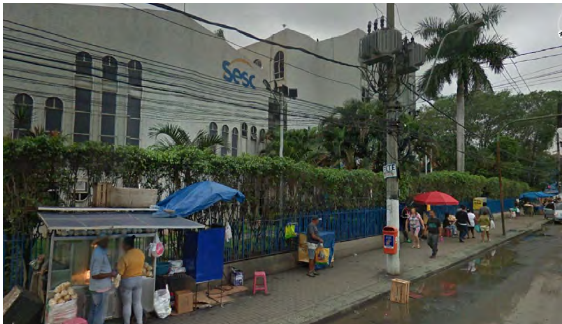
Figura 15: Fachada do SESC São João do Meriti na Avenida Automóvel Clube, próximo ao Rio Pavuna. (Fonte: Google Street View)
