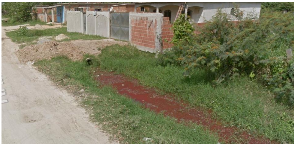
Figura 80: Foto de Irinéia Verçosa do bairro Campo Lindo com lançamento de esgoto a céu aberto. Fonte: acervo do autor.
