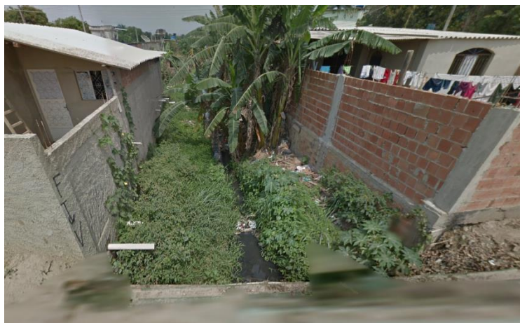
Figura 84: Imagem do Valão do China no bairro Campo Lindo mostrando o estreitamento de sua seção. Google Street View .
