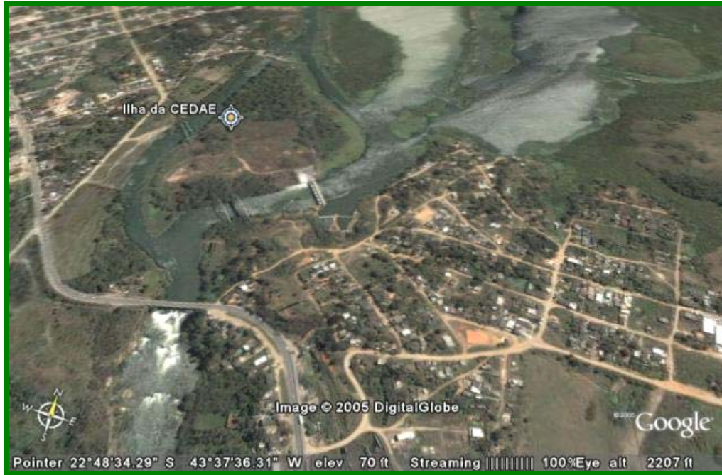
Figura 1. Foto de satélite do Rio Guandu, mostrando a Ilha da CEDAE, a barragem da (ETA) Estação de Tratamento de Água e a antiga estrada Rio - São Paulo (BR-465).
