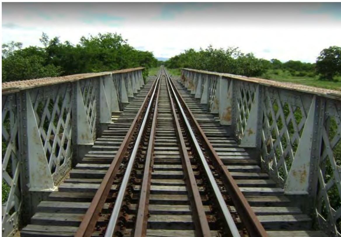
Figura 2: Linha férrea em travessia no Rio Tabuleiro, divisa municípios de Mato Verde e Catuti - MG. Fonte: OLIVEIRA, 2018.
