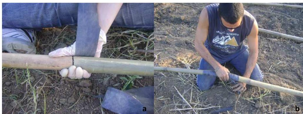
**Figura 7.** Conexão entre os dutos das linhas laterais, a) ajuste das extremidades dos dutos, e b) vedação com luva de câmara de ar.
