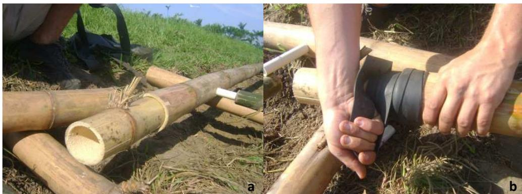
**Figura 4.** Tamponamento do ramal, a) introdução do tampão, e b) vedação do tampão.
