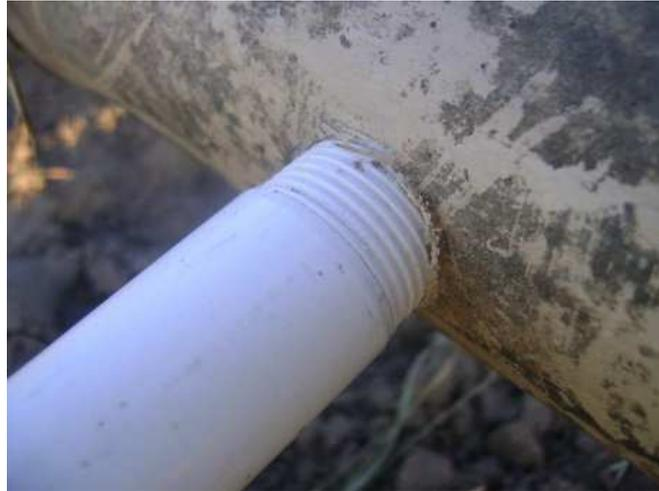
**Figura 5.** Montagem da tomada de linha lateral
