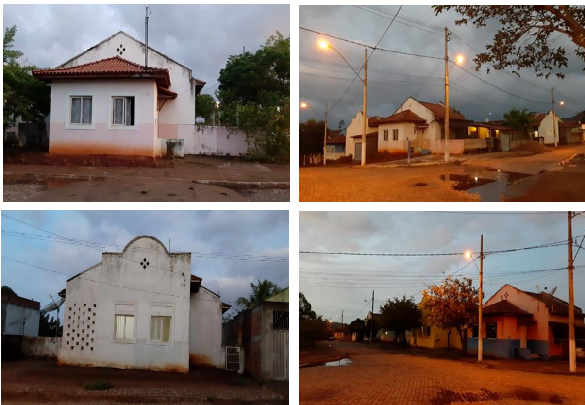
Figura 14 - Bairro Vila União em Salto da Divisa – MG após reivindicação dos atingidos pela UHE Itapebi
