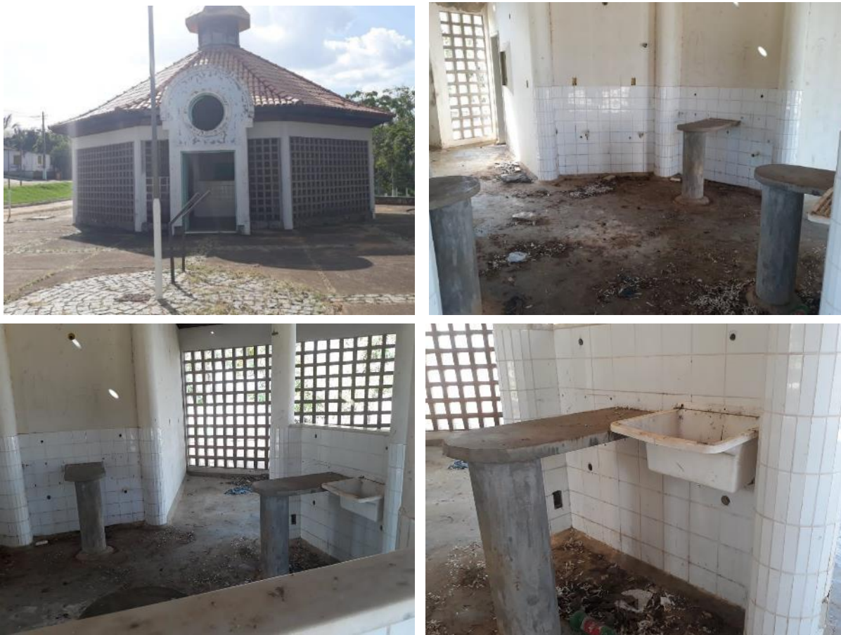
Figura 17 - Lavanderia Pública construída pela UHE Itapebi em Salto da Divisa - MG
