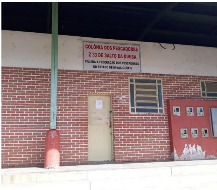
Figura 10 - Colônia dos Pescadores de Salto da Divisa - MG
