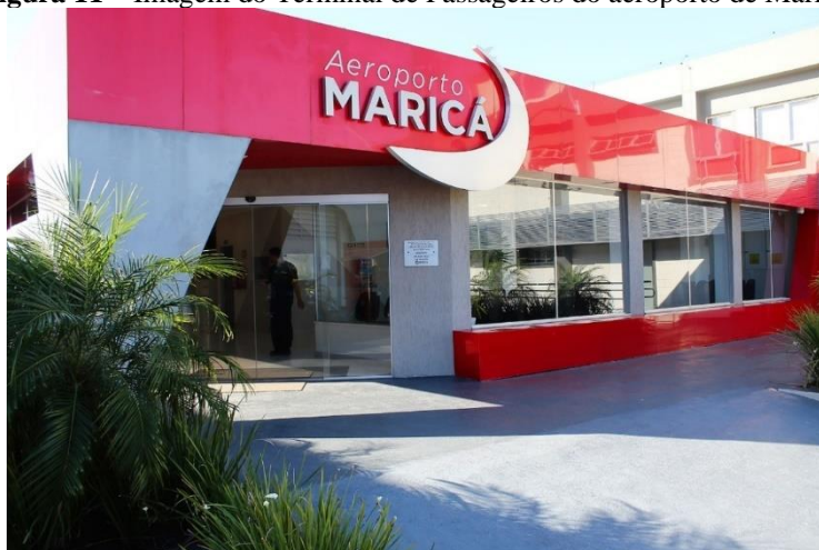
Figura 11 – Imagem do Terminal de Passageiros do aeroporto de Maricá.
