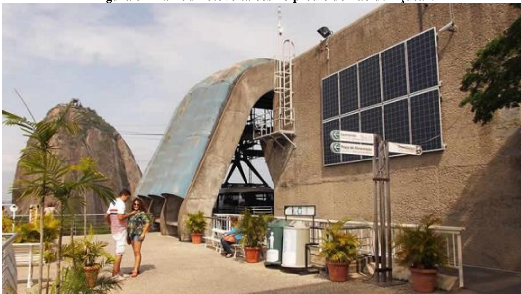
Figura 8 – Painéis Fotovoltaicos no prédio do Pão de Açúcar.
