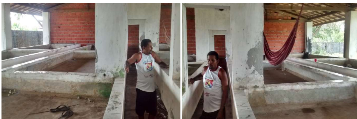
Figura 32 - Galpões usados no empreendimento construído em Graciosa
