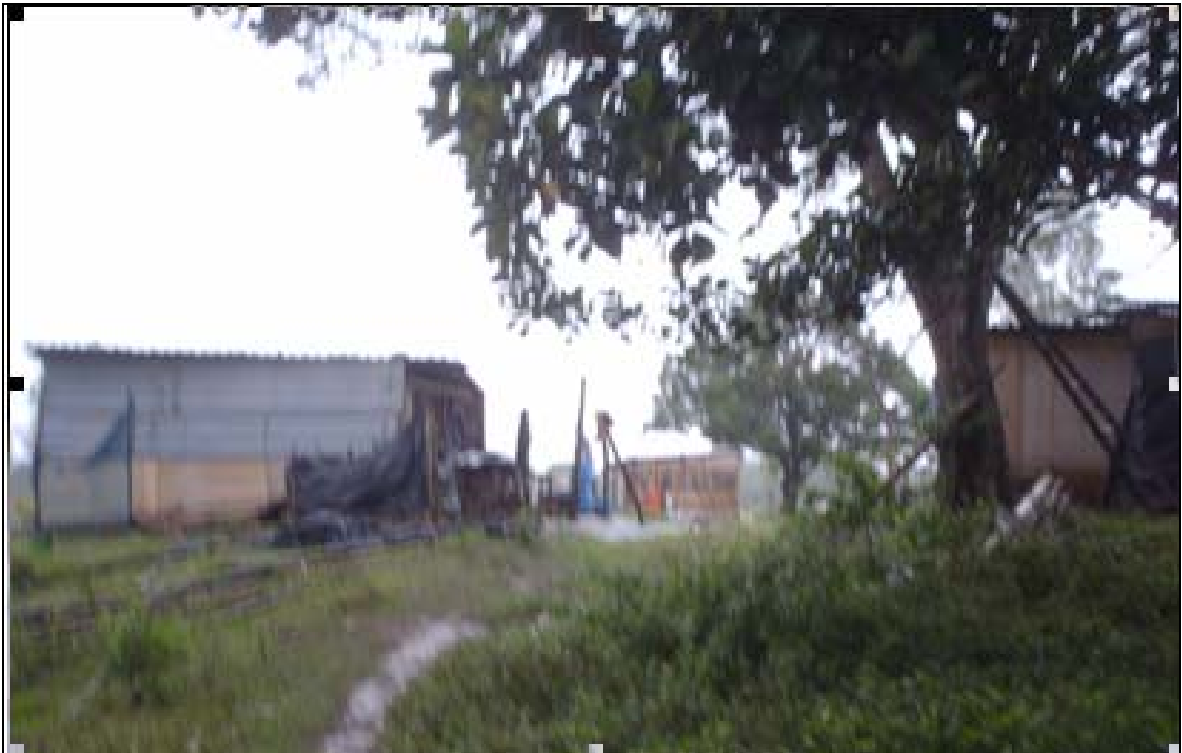
Barraco construído com madeira e lona preta – Duque de Caxias
