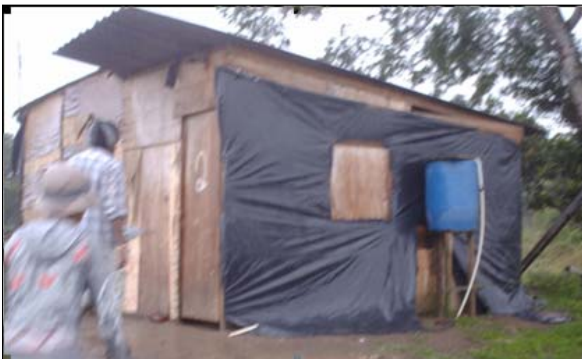
Barraco construído com madeira e lona preta – Duque de Caxias
