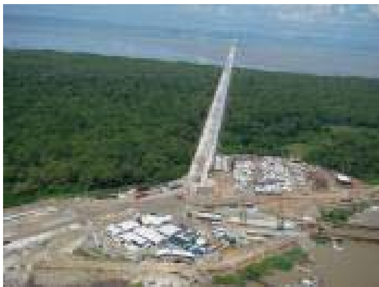
Imagem 4 - Canteiro de obras em Santa Cruz
