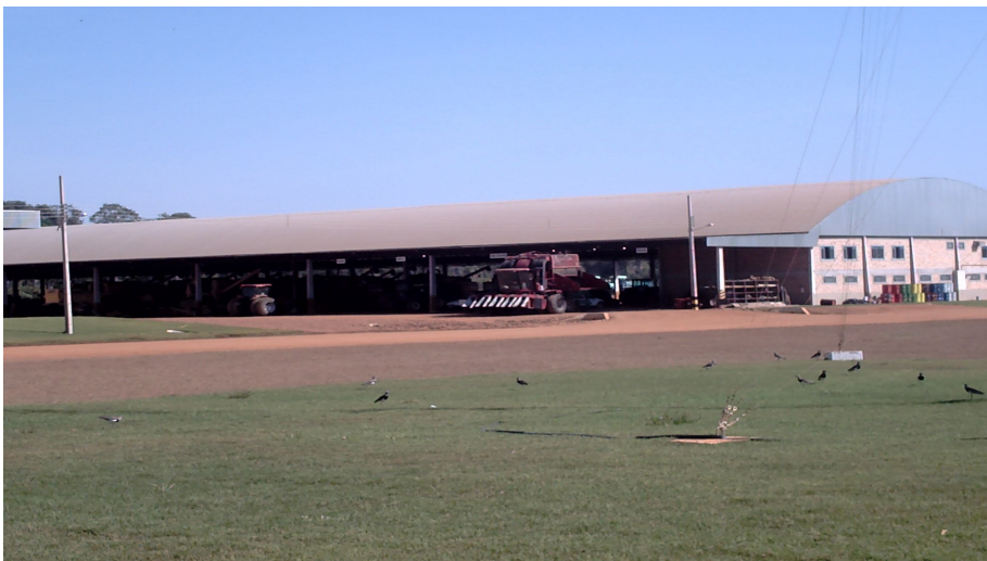
Foto VII – Vista externa do galpão de máquinas da Fazenda Tanguro, Querência Mato Grosso
