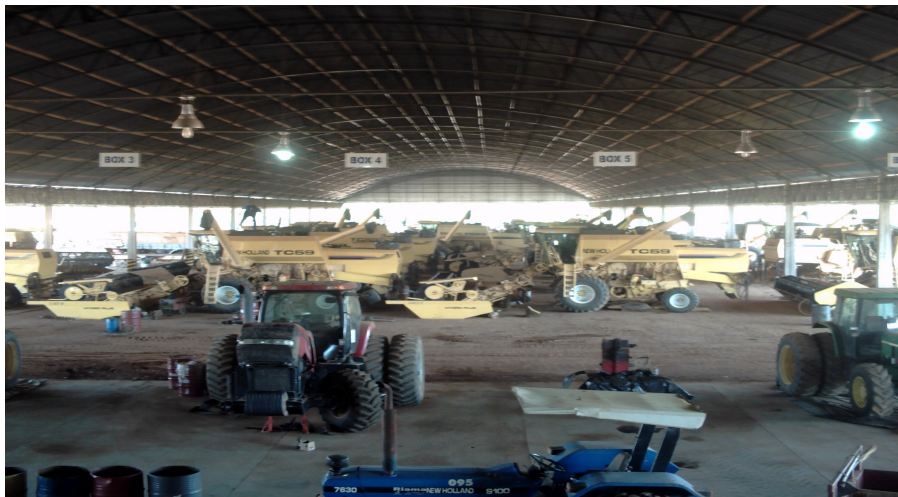
Foto VIII - Vista interna do galpão das máquinas
