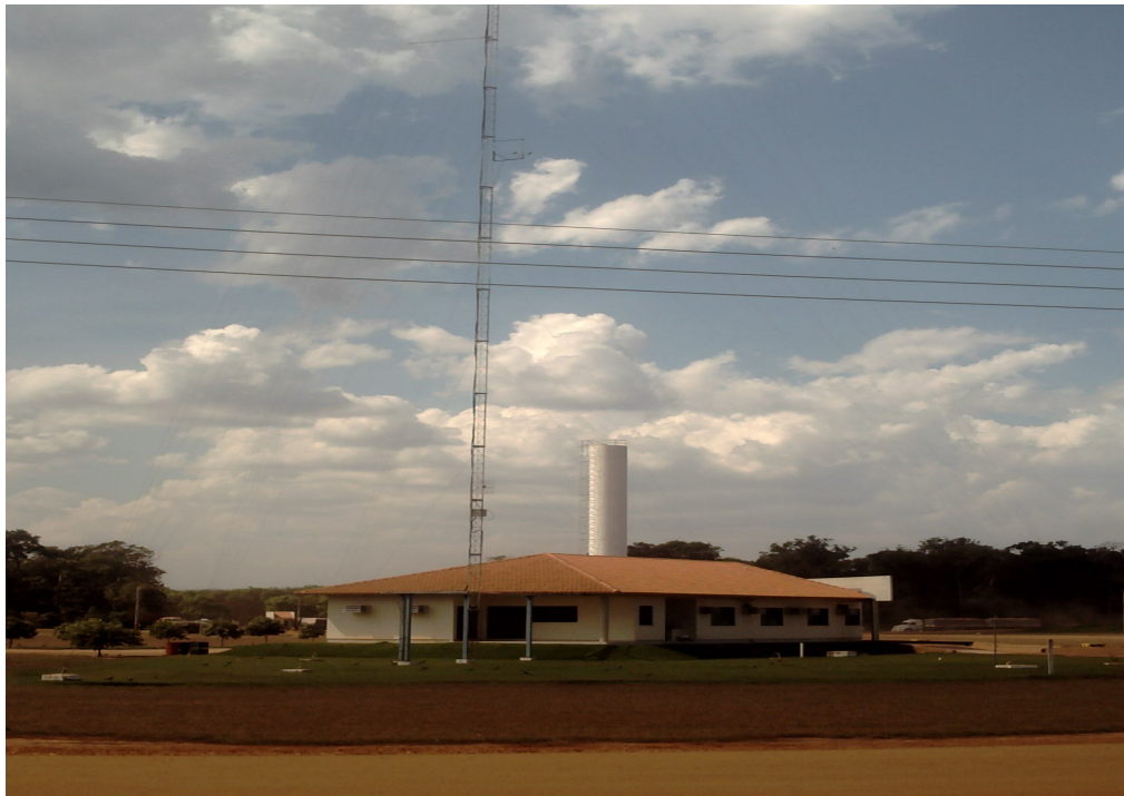
Foto X– Torre de telecomunicação no interior da fazenda Tanguro
