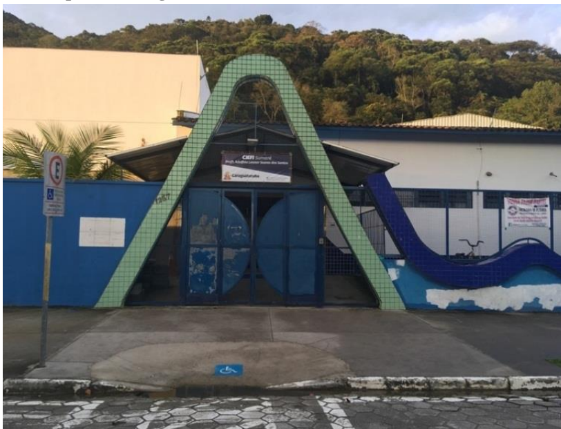
Figura 9 – Escola Municipal de Caraguatatuba
