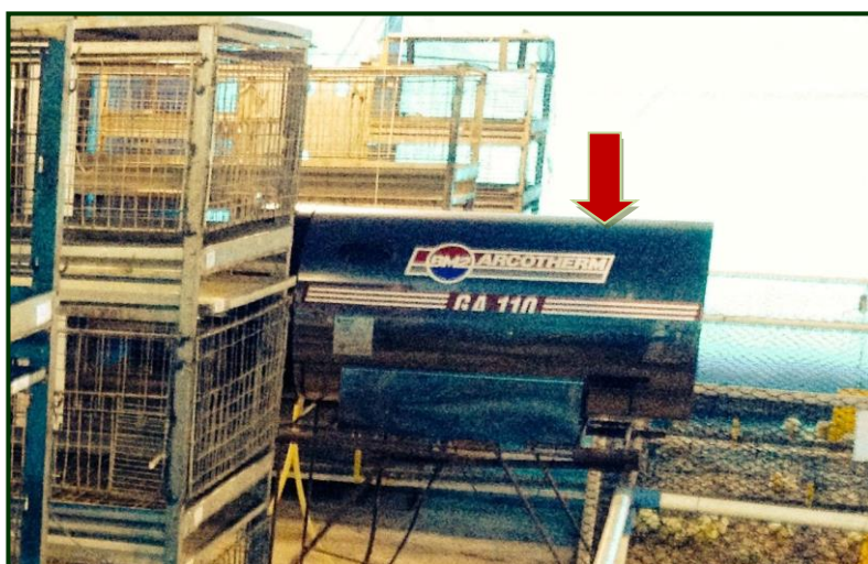
Figura 7. Aquecedor automático (modelo ARCOTHERM GA110) a gás utilizado para aquecer todo o ambiente do galpão experimental
