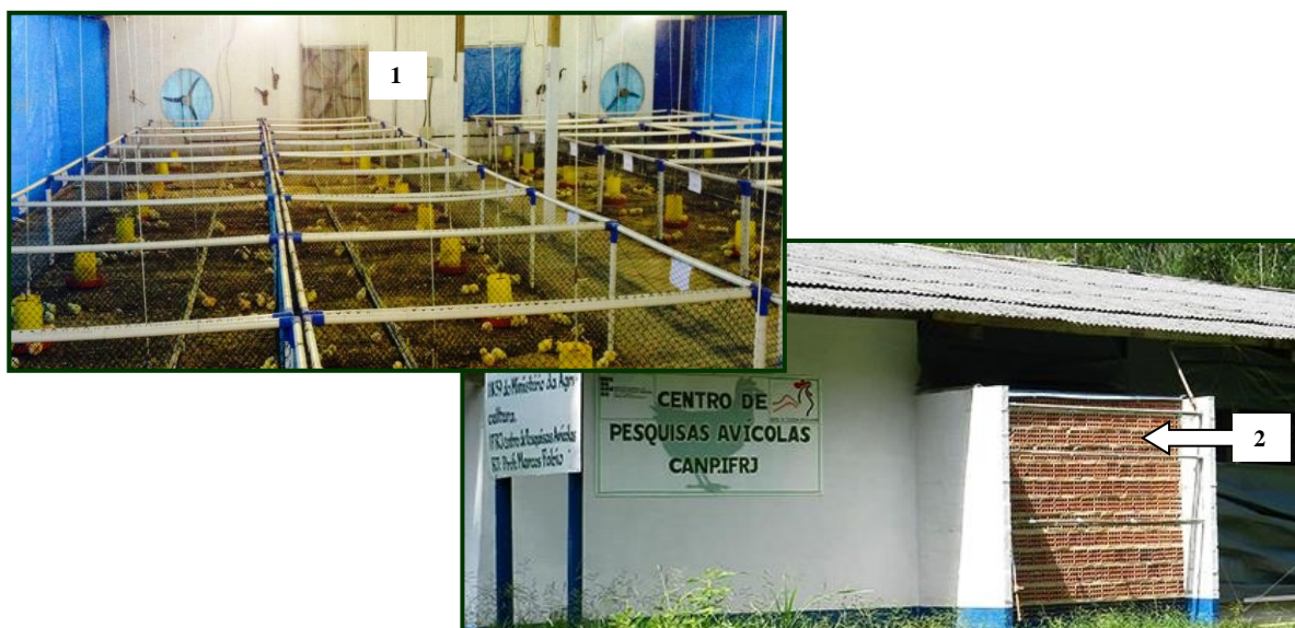
Figura 8. 1- sistema de ventilação túnel através de exaustores. 2 - placa evaporativa adaptada através de tijolos de barro e nebulizadores externos
