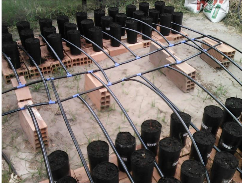
Figura 10: Detalhe das duas linhas de derivação e vinte linhas laterais.
