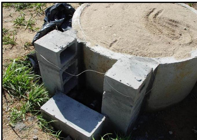
Figura 2 - Base de dreno compondo o último anel das colunas de cimento
