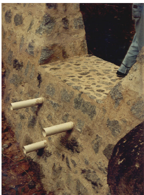
Dique em 1993. (B)
