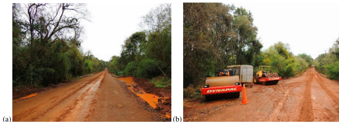
Figura II.12: Ruta 101. (a) Trecho de terra. (b) Trecho sendo pavimentado com pedras. Fonte: A autora.
