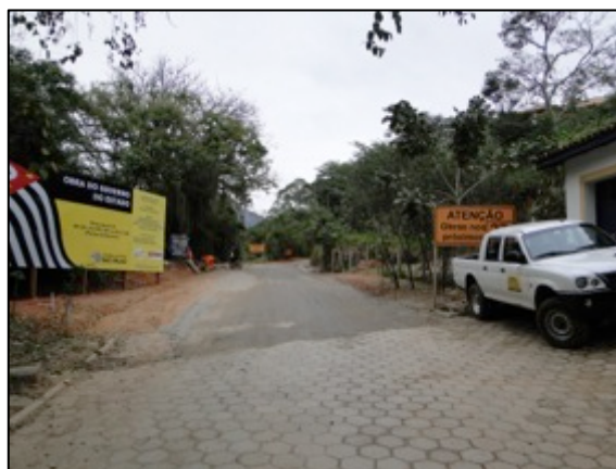
Figura 23: Obras na estrada de acesso ao PNSB
