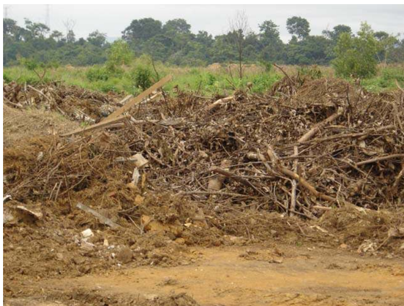
Figura 2: Amontoamento dos resíduos na AE-3 da UHE Tucuruí.
