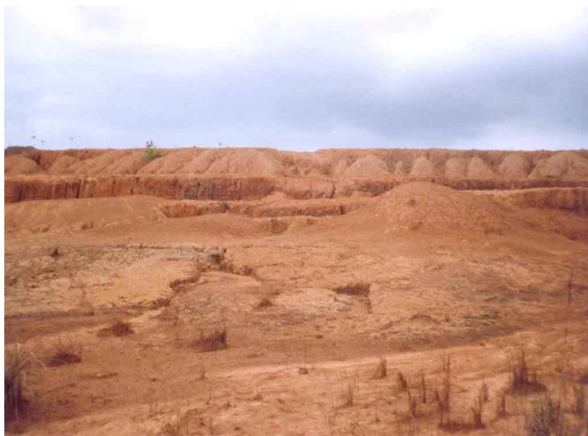
Figura 2: Estado de degradação da área AE-2 em 1998, após 18 anos de abandono (Fonte: CONSÓRCIO ENGEVIX THEMAG, 1998).
