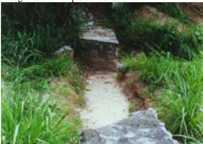
Fotografia 14 – Dique de fechamento
