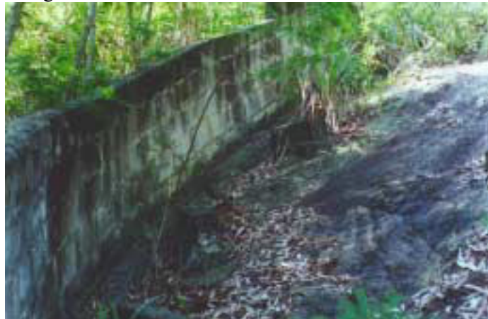
Fotografia 7 – Muro de desvio
