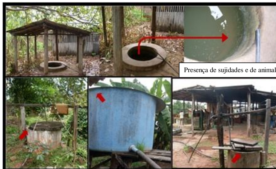
Figura 10. Abastecimento de água nas unidades processadoras. Em destaque falhas no sistema de vedação dos poços tipo cacimbão e caixa d'água.
