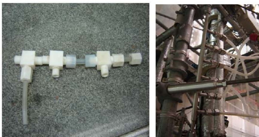
Figura 8. Manifold original e o novo modelo em aço inox soldado
