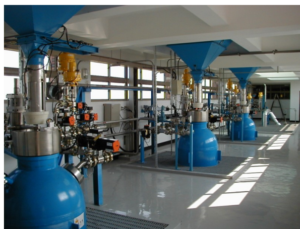
Figura 8 – Planta industrial de extração supercrítica situada em Taiwan (Fonte: http://www.natex.at , 2010).
