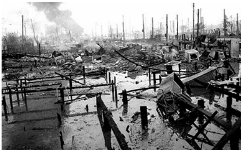
Figura 13 – Destruição da Vila Socó em Cubatão, São Paulo (Fonte: http://zonaderisco.blogspot.com , 2010)
