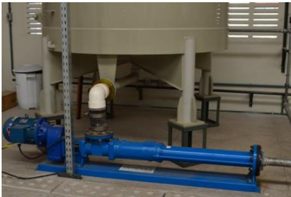
**Figura 3.11** - Bomba helicoidal de deslocamento positivo (Bomba principal).
