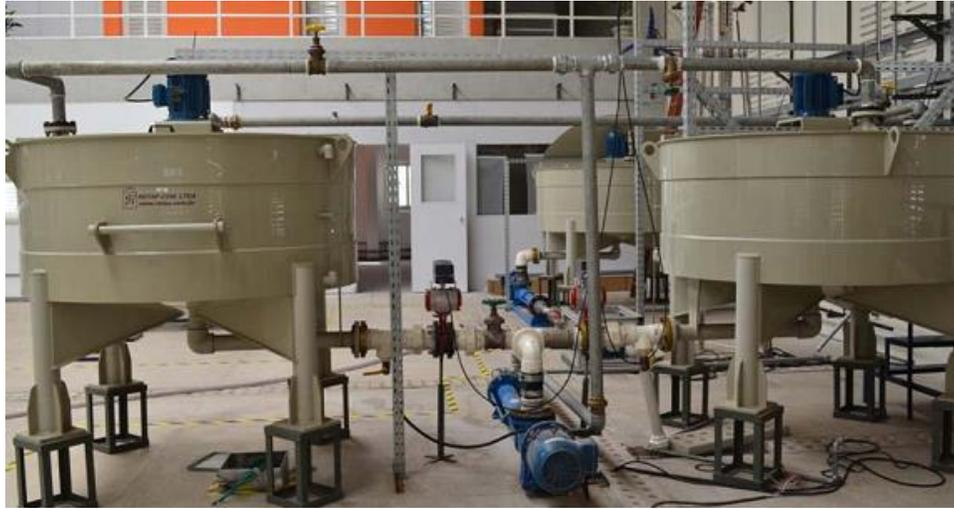
**Figura 3.12** - Bomba helicoidal de deslocamento positivo (Bomba lama).
