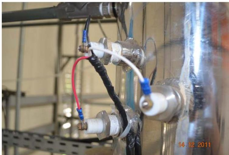
**Figura 3.9** - Sensor de nível para tanque de pressão.
