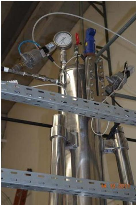
**Figura 3.6** - Válvulas de entrada e saída de ar comprimido.
