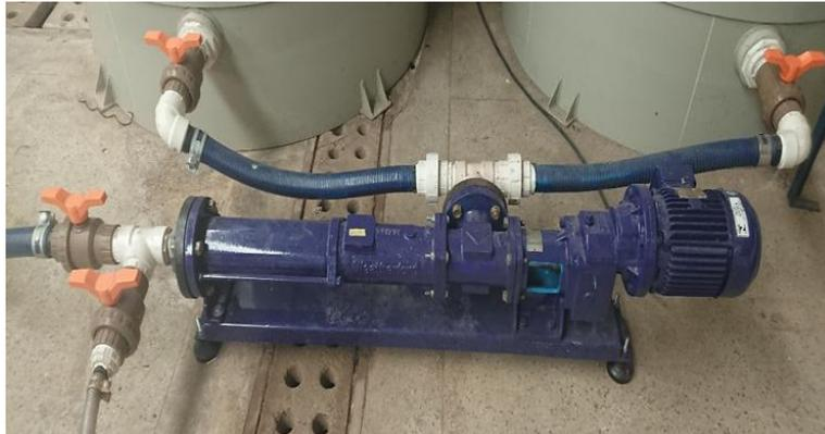
Figura 19 – Bomba posicionada na saída dos tanques de armazenamento.
