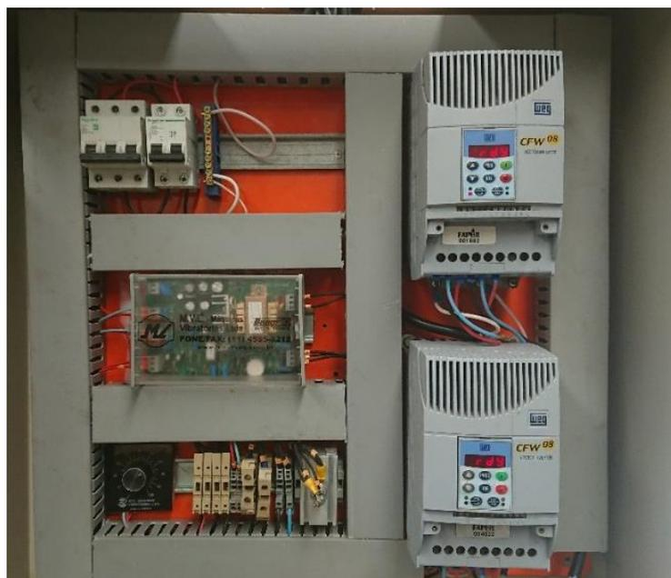
Figura 34 – Quadro dos inversores de frequência.
