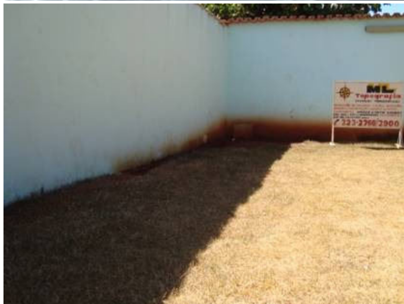
Figura 1. Impacto de uma gota sobre o solo (a); efeito do salpicamento em muro (b).
