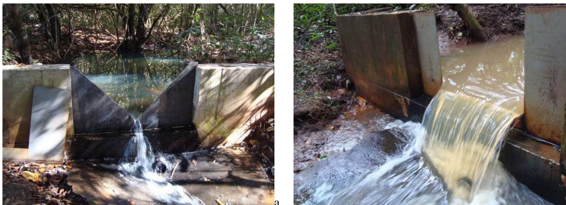
Figura 12. Vertedor em operação nas diferentes épocas do ano. Vertedor triangular – mês de agosto de 2010 (a) e retangular – mês de fevereiro de 2011 (b) de parede fina instalado no exutório da microbacia.
