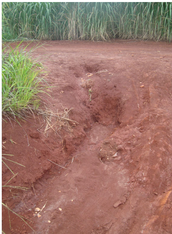
Figura 3. Erosão em sulco.
