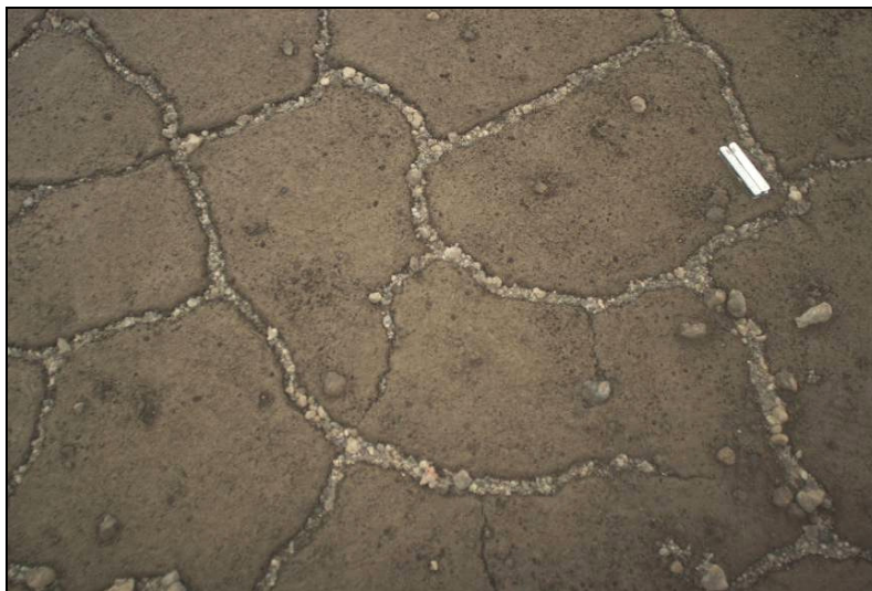
Figura 18. Superfície do perfil 8, onde se destacam as rachaduras.
