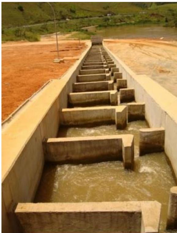
**Figura 2.** Vista parcial da escada de peixes do tipo ranhura vertical de jato único da PCH Queluz no rio Paraíba do Sul.
