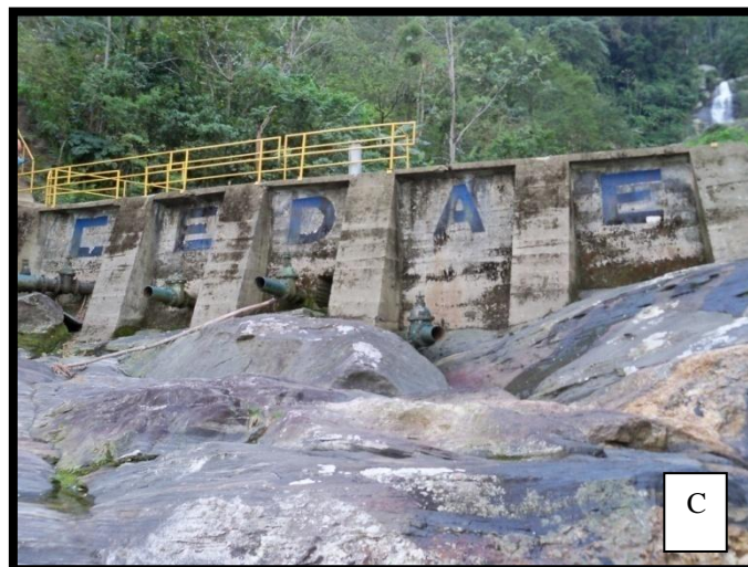
Figura 22: Cachoeira Itingussú A) Queda d'água; B) Cachoeira vista a partir da Rodovia BR-101; C) Delimitação da cachoeira para captação de água pela CEDAE. Fotos: DOFS.
