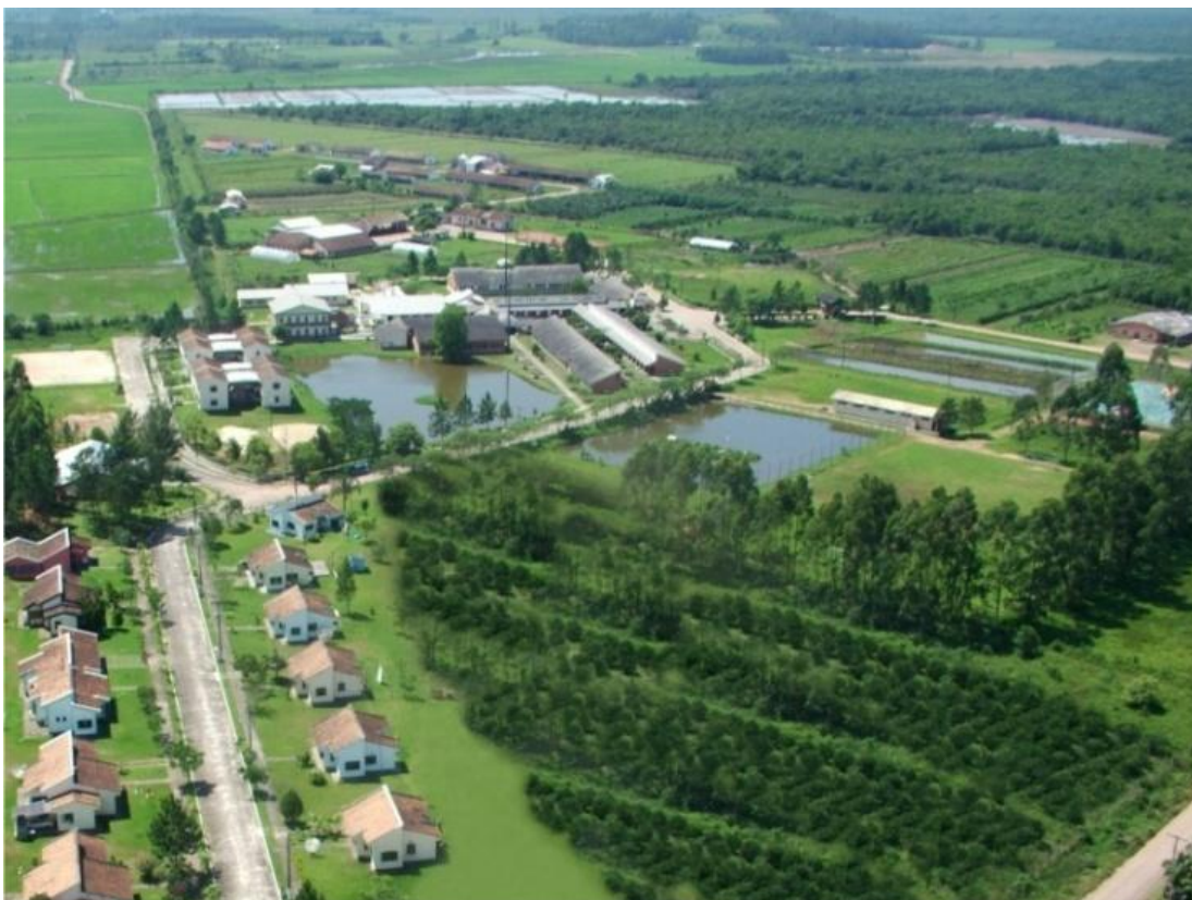
Figura 04: Vista aérea da Sede do IFC/Sombrio.
