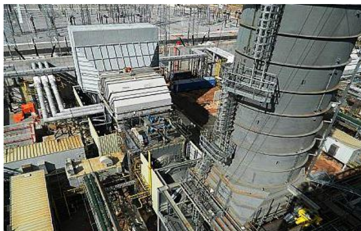
Figura 5 - Usina Termoeletrica Barbosa Lima Sobrinho - Jardim Maracanã - Seropédica - RJ.
