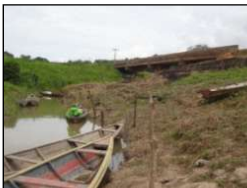
Figura 03. Ponte entre Umariçu I e II. Fonte: Próprio autor.
